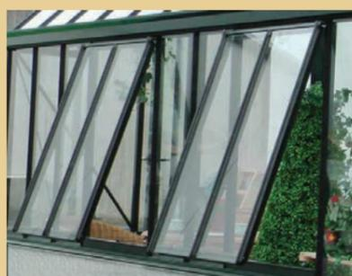
Stehwandflügel Fenster lang bis zur Mauerhöhe
