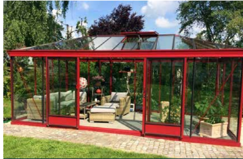
Dach 16 mm Isolierglas VSG Seitenwände 14 mm Isolierglas
