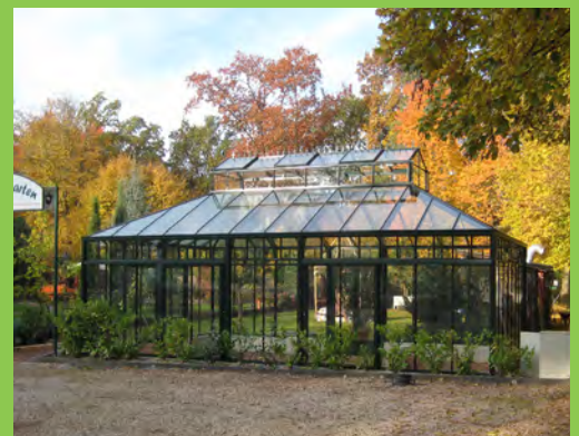
Walmdach mit Kuppel
