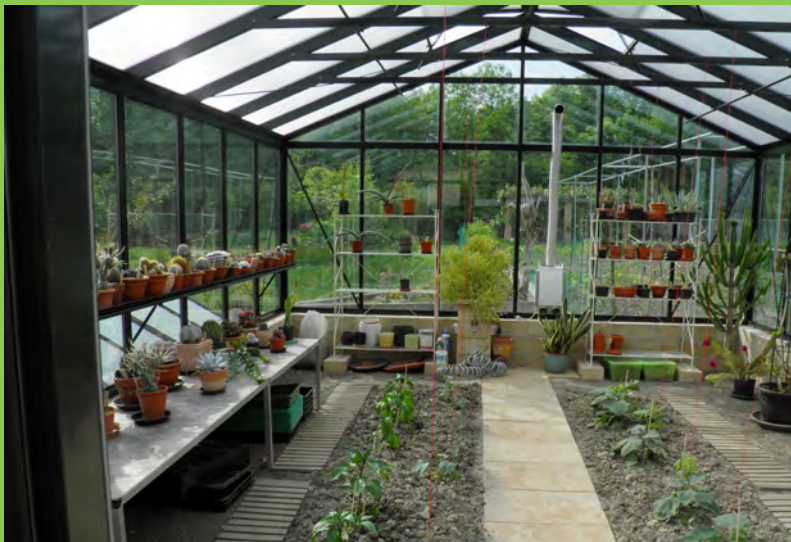
Dach 16 mm Stegdreifachplatte Seitenwände 14 mm Isolierglas
