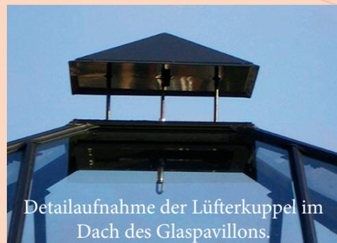
Detailaufnahme der Lüfterkuppel im Dach des Glaspavillons.
